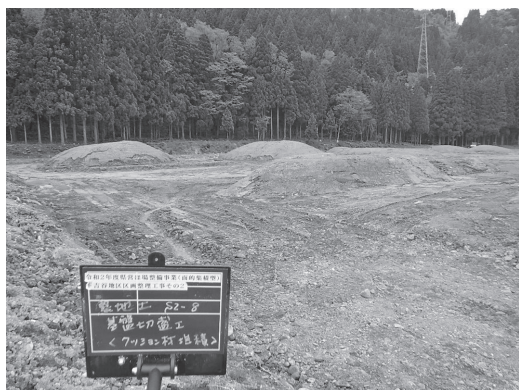
写真3 クッション材の集積状況(手前の山がクッション材で奥の山が表土)
