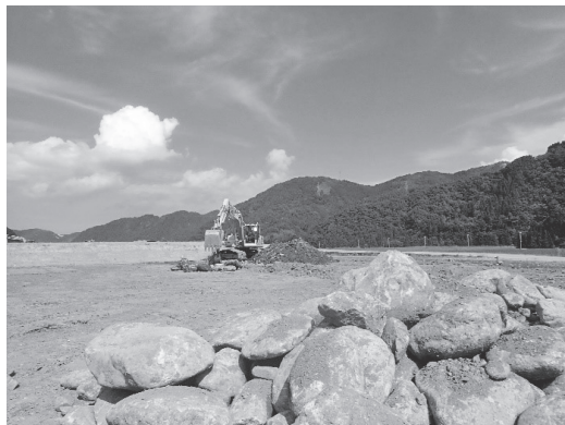
写真4 石礫の埋設状況
