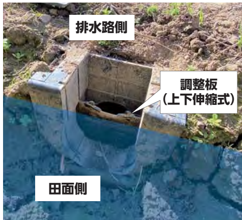
▲谷地南部地区活動組織が設置している排水ます。伸縮式の調整板で貯水・排水量を調整できる仕組み。(10月7日 谷地字月山堂地内)
