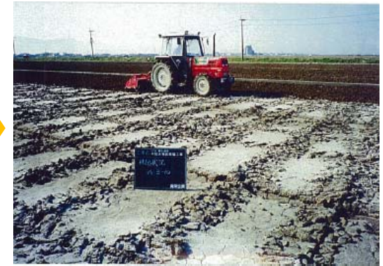
③石灰系土壌改良 資材の投入
