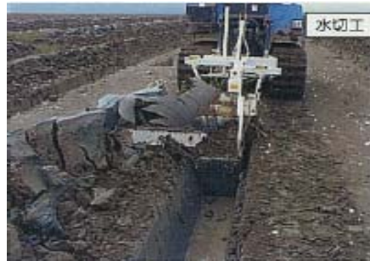
②仮排水路・ 水切溝の設置
