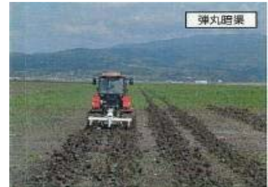
④弾丸暗渠の施工
